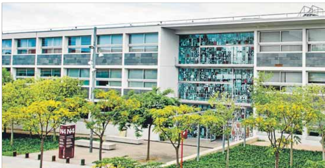
La façana de l'edifici de la Facultat de Química de la Universitat Rovira i Virgili ■ URV
